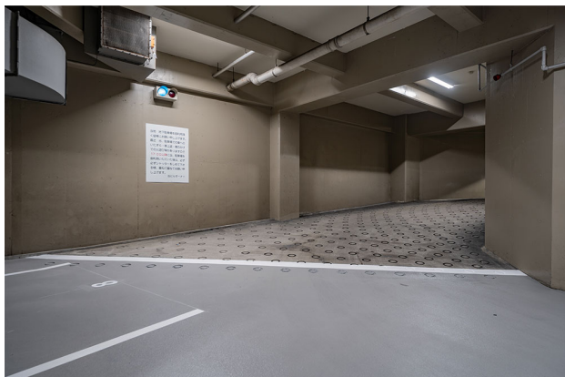
駐車場入口の車路
