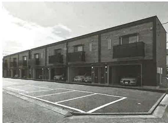
プレミアムガレージハウスの物件。軽量鉄骨造で高いメンテナンス性を持つ（写真提供：プレミアムガレージハウス）
