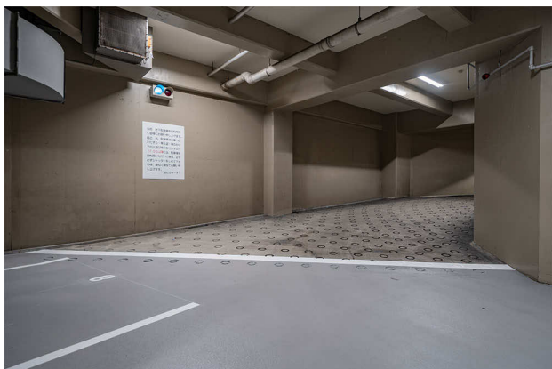
駐車場入口の車路
